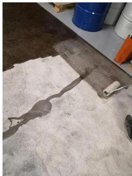
Verser le mélange sur le sol au fur et à mesure de la pose et étaler avec un rouleau.
