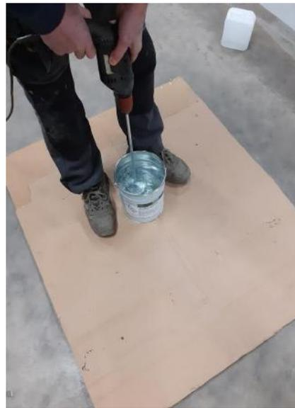
Verser la totalité du composant B dans le seau du composant A et mélanger 2 à 3 minutes.
