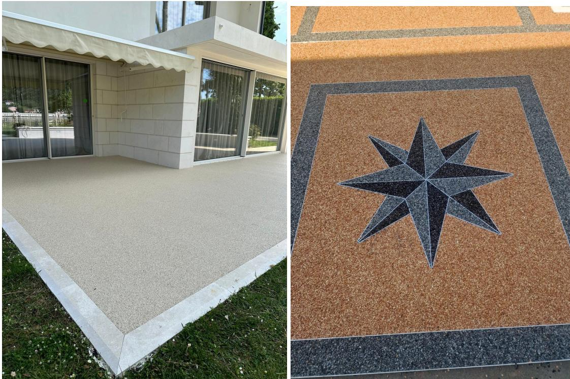
**Qu'est-ce qu'un sol drainant?** Un sol drainant est une surface qui laisse passer l'eau de pluie, évitant la stagnation et réduisant les risques d'inondation. Il est composé de gravier et de résine, assurant une dispersion efficace de l'eau.
