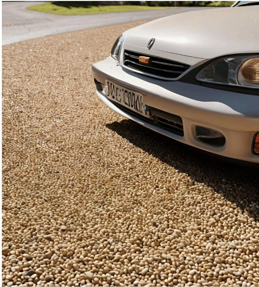
**Quelles conditions sont nécessaires pour appliquer un sol drainant :** La résine catalyse à des températures de 10°C à 45°C. À basse température, les temps de durcissement sont prolongés. Par exemple, en travaillant à 10°C, la résine est praticable en 24 heures et carrossable en 48 heures.
